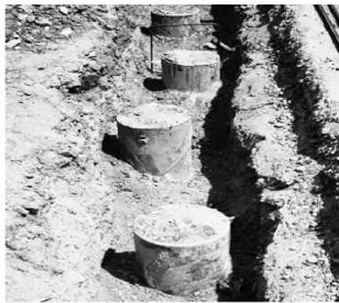
图 2 反开挖桩头后的钢管桩
