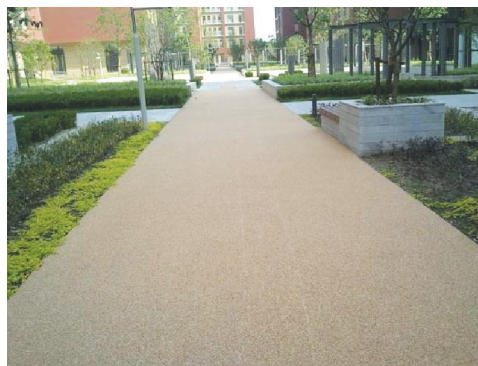
b 透水性水泥混凝土路面
